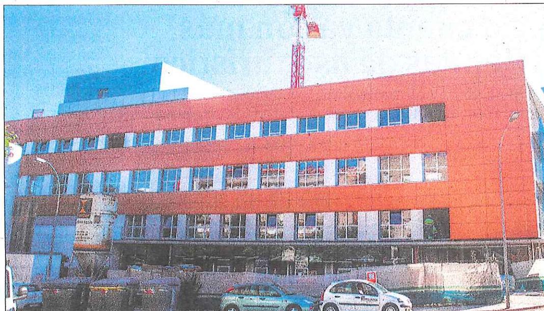
Vista lateral del nuevo bloque del edificio del Hospital Santa Bárbara. GONZALOMONTESEGURO
